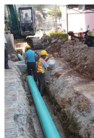
東芝テック深圳社 水道管の漏水予防工事
