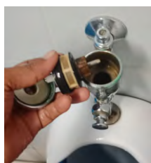
社内設備の漏水点検 テックインドネシア社
