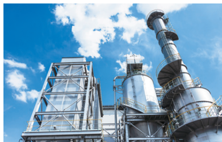
▲2022年に新設した発電用バイオマスボイラ。廃材を主原料にした 木質チップや固形燃料を使い、年間8万3000トンのCO 2 削減を目指す
